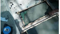
FIG.3.11: LAYING OF SCC LAYER BY LAYER
